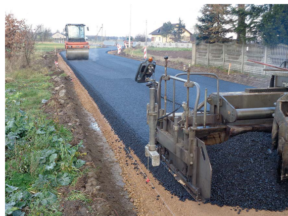
fot. Przebudowa drogi Witkowice – Rzerzeczycze
