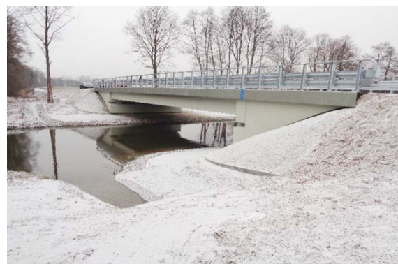
fot. Most w Skrzydlowie po przebudowie
