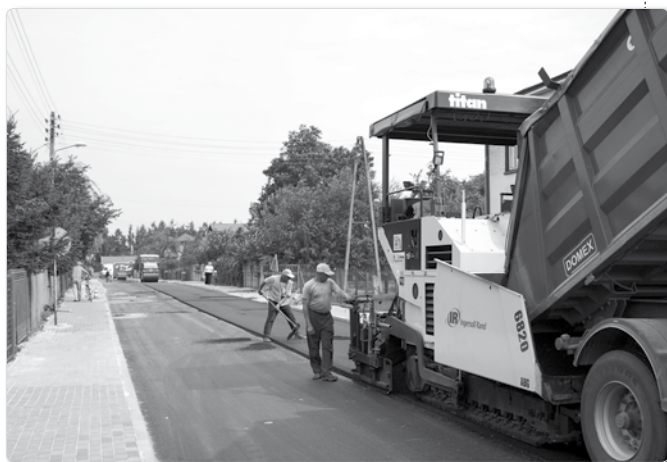
Roboty na ul. Strażackiej
